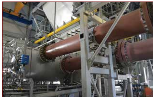
obr. 4 Inštalácia tandemového kompresora 2BCL602 na KS05 Zdroj: Eustream
